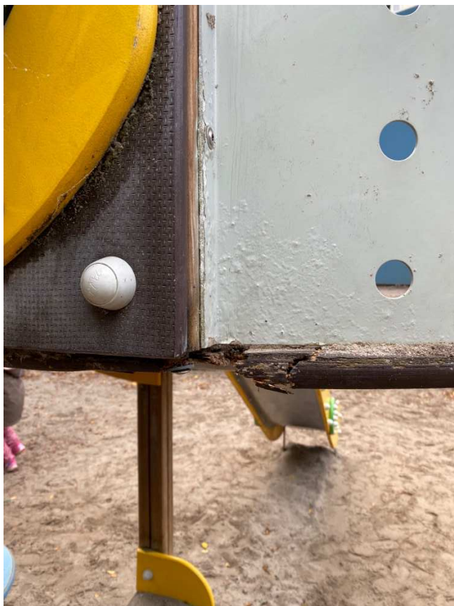
Legepladsens tårn m. ruchebane har fået skiftet 1 af 3 bundplader – inden længe er der behov for yderligere et bræt skiftes idet det smuldre.
