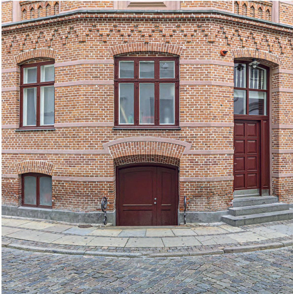
Fotoregistrering Eksisterende forhold
