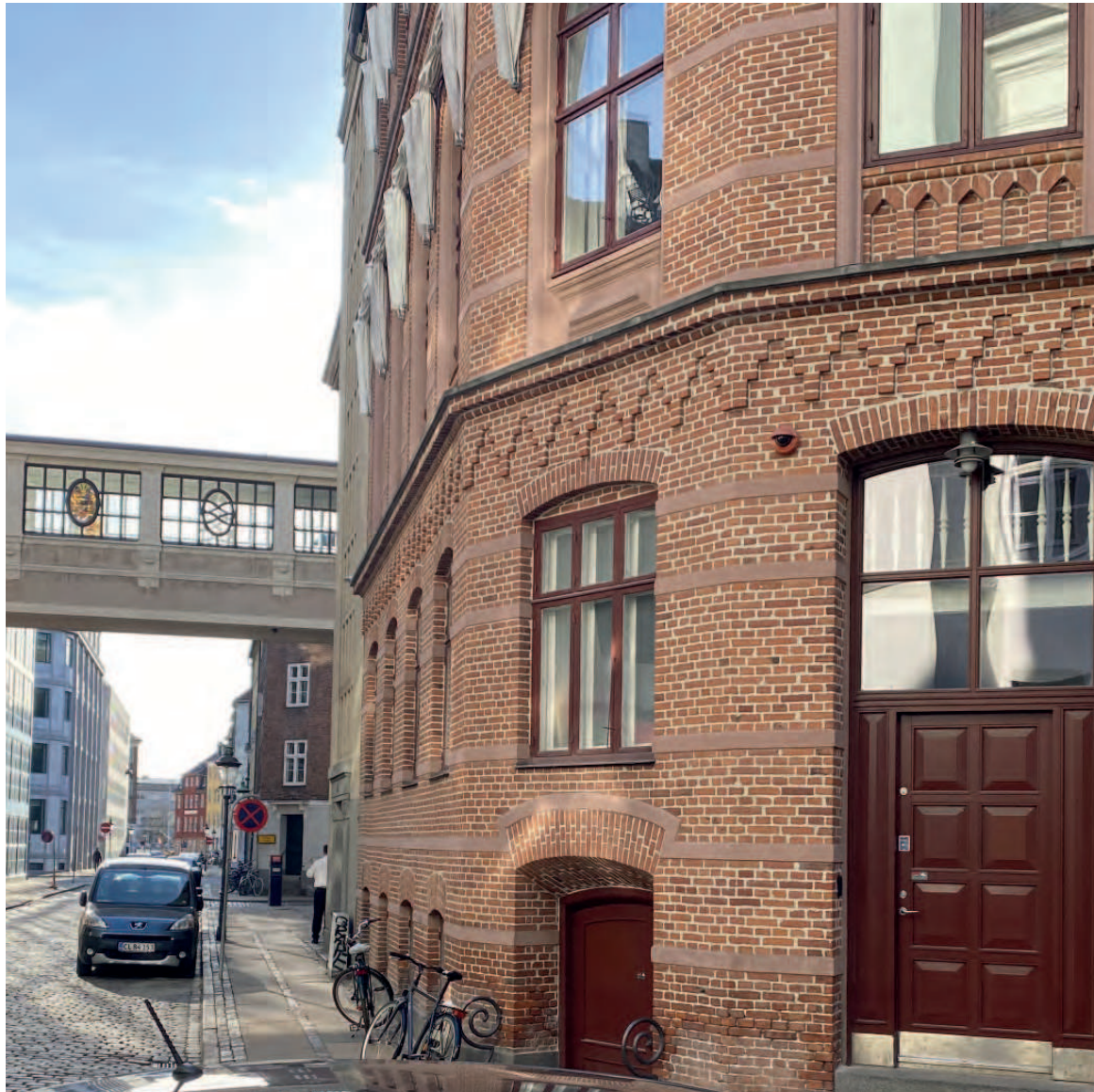
Fotoregistrering Eksisterende forhold
