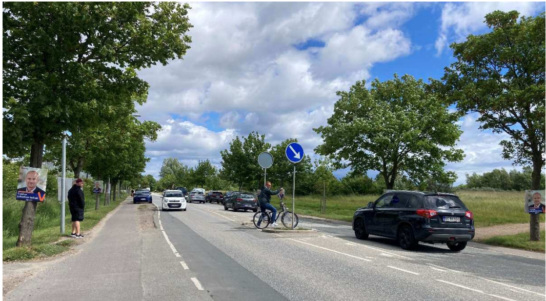
Figur 8: Eksempel på krydsende cyklister ved den to meter brede krydsningshelle
