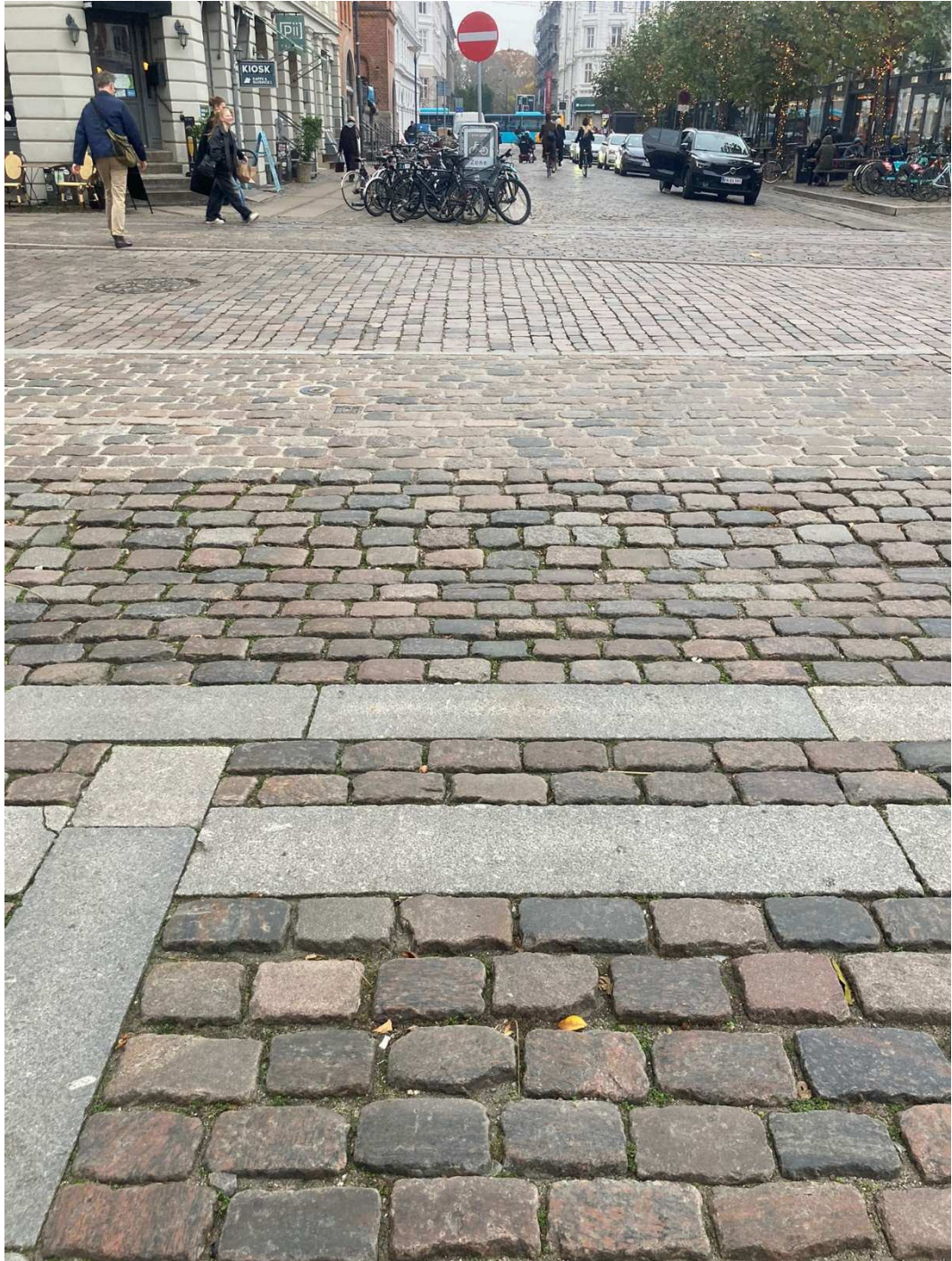
Figur 43: Eksempel af mange forskelligartede belægninger. Belægningerne varierer i tekstur, fugestørrelse, farve, læggeretning mm. Fotoet illustrerer at man med granitmaterialer kan lave tydelig forskel på anvendelse. Fotoet er fra Israels Plads.
