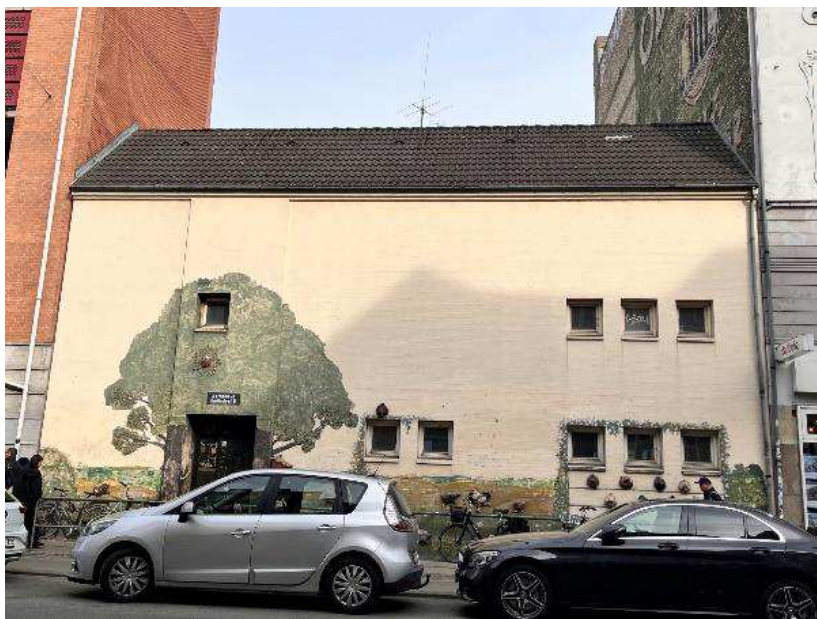
(Foto, taget af forvaltningen. Billede af bygningen, som ønskes nedrevet)
