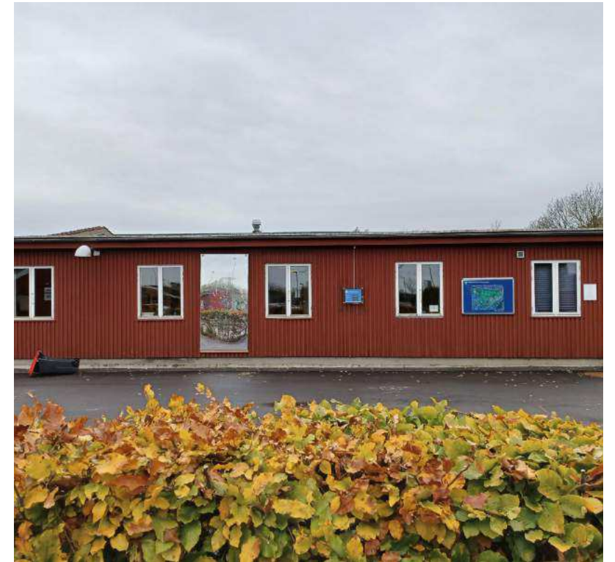
HÅRD BELÆGNING OMKRING BARAKKER
