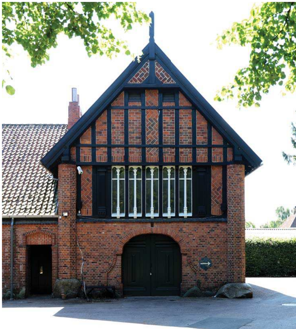
EKSISTERENDE FORHOLD | FACADER OG MURVÆRKSDETALJER
