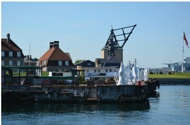
Et kig mod Nyholm med maste Kranen
