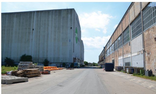
Bygningsproportionerne er store på Refshaleøen. Her mødes det gamle og det nye skibsværft med den gamle svejsehøle til højre og sektionshallerne til venstre.
