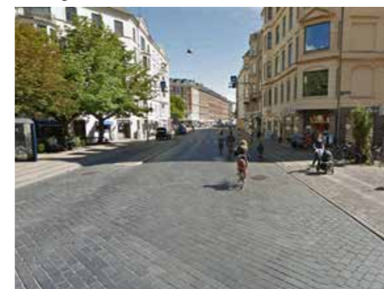
Hævet kørebane med materialeskift langs Victor Borges Plads på Nordre Frihavsgade som fartdæmpende foranstaltning
