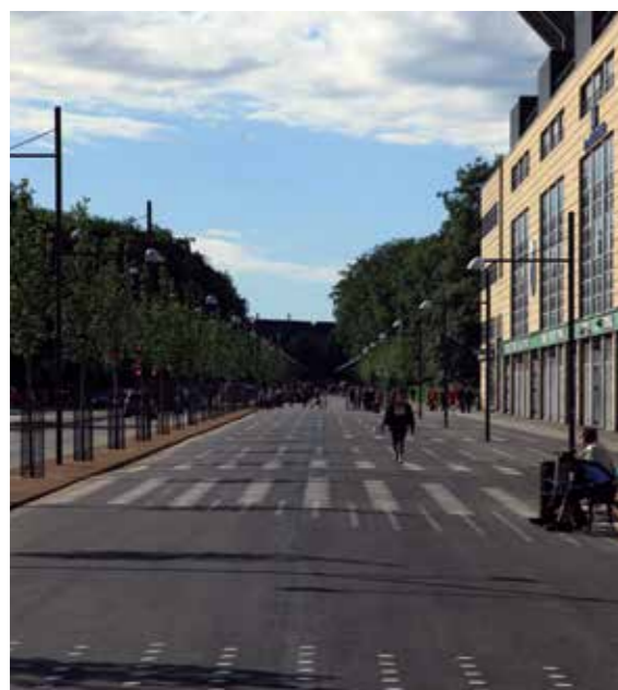
Vejbemaling i termoplast markerer blød trafik og tværgående trafik langs Parken på Øster Allé
