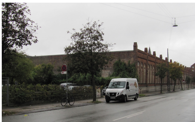
Shedtagsbygningen mod Hamletsgade, hvis facade ønskes åbnet og tom grund med mulighed for huludfyldning
