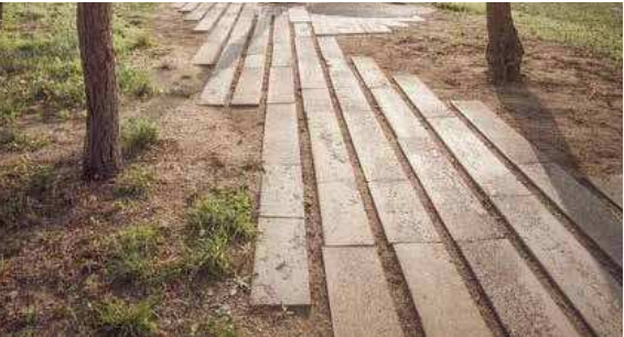
Genbrug og mindskning af materialebrug. De ukurrante former genbrugsmaterialer kan komme i skaber potentialet for at bruge dem med afstand – sammenligneligt med græsarming. Metoden mindsker brug af materialer og øger arealer for det voksede.
