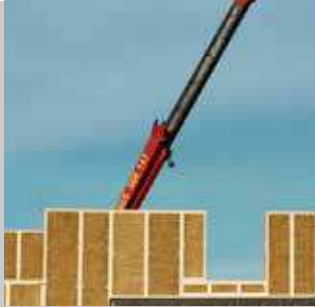
Halm Et velkendt biogent materiale er halm. Udover materialets lethed og isolerende kvalitet bliver det også produceret som halmballelevægge. Materialets akustiske egenskaber skaber sanseligt stimulerende rum.
