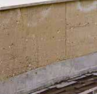
Jord Stampet lerjord kan bruges som bærende element i lette konstruktioner, det er potentielt lokalt tilgængeligt i Nordør og det vil også kunne genanvendes i et cirkulært perspektiv.
