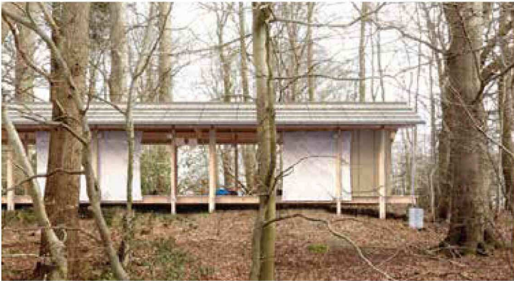
Houens Odde Spejdercenter, Pihlmann (konkurrenceforslag) Et eksisterende punktfundament, som de nye bygninger bygger ovenpå. Det løftende greb skaber en lethed og lader huset fremstå svævende. Houens Odde Spejdercenter, pihlmann (konkurrenceforslag).
