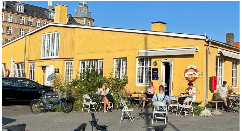
Eksisterende bygning på Wilders Plads 11 A og 11B set fra øst. Bygningen kan nedrives og erstattes af ny bebyggelse. Foto: Lundgaard og Tranberg arkitekter.
