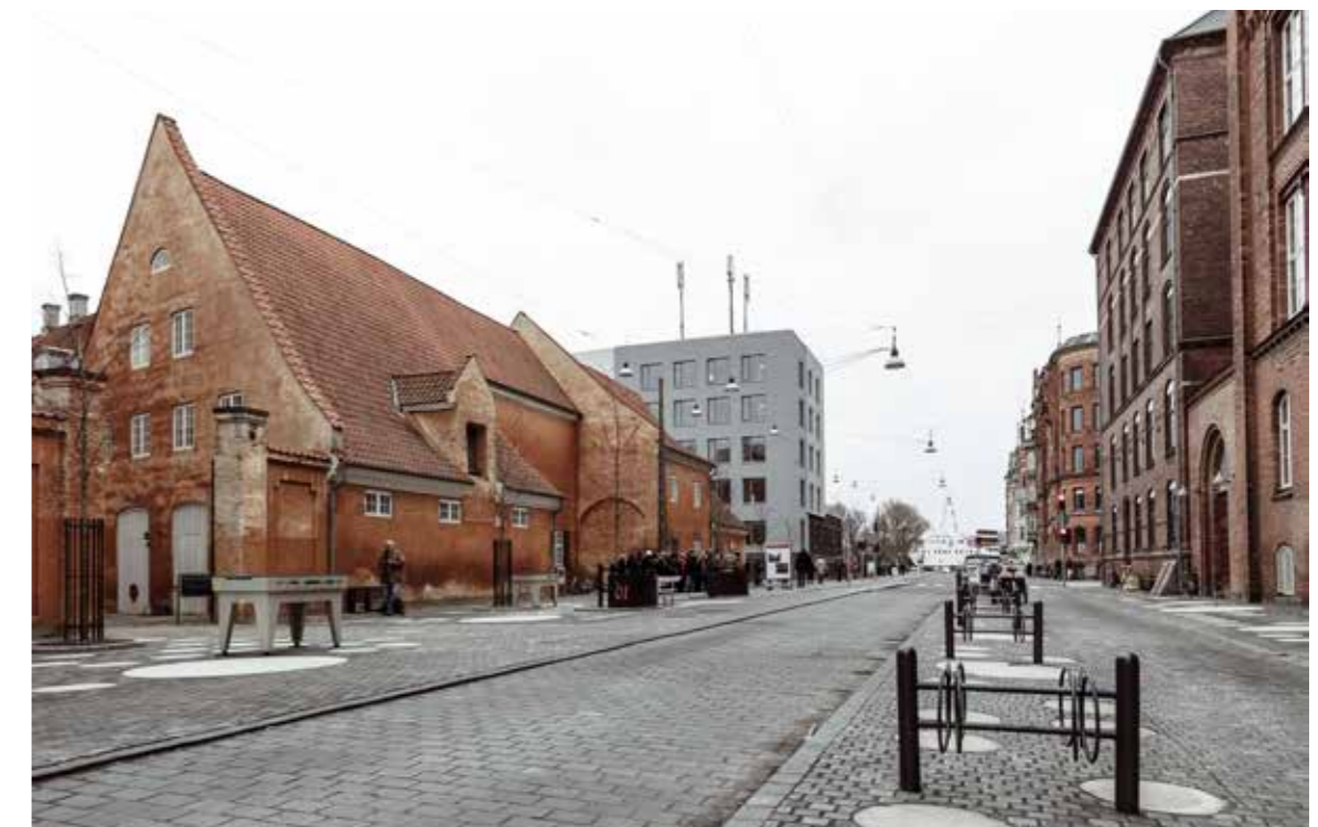
Sivegade ved skole på Vester Voldgade, med fælles karakter gennem hele vejprofilen
