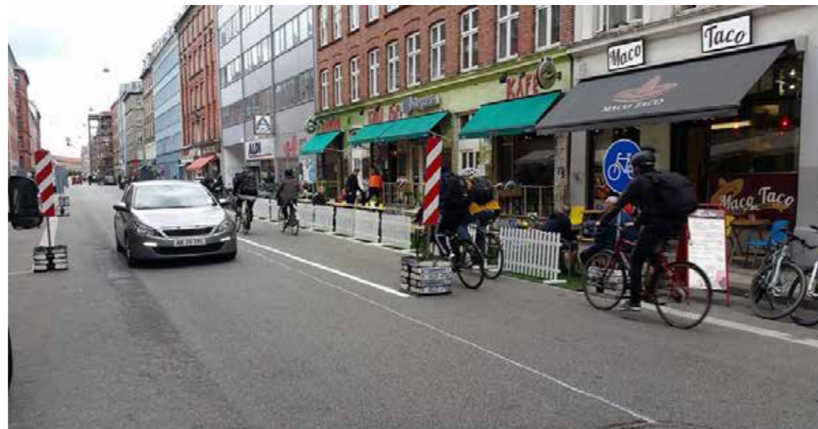
Vejindsnævring skaber mulighed for cykelsti i begge retninger, samt flexområde i den ene side
