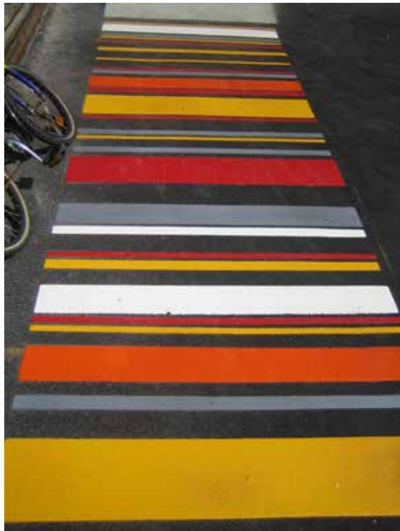
Thermoplast i form af henholdsvis striber og cirkler markerer den tværgående trafik overfor hinanden. Ruten, Tingbjerg.
