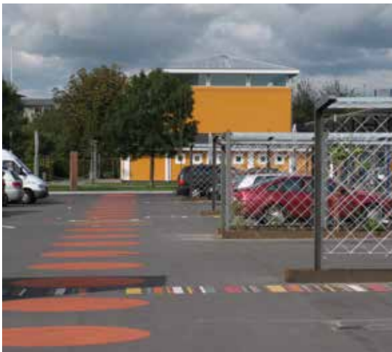
Thermoplast i form af henholdsvis striber og cirkler markerer den tværgående trafik overfor hinanden. Ruten, Tingbjerg.
