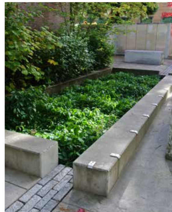
Grøn regnvandsforsinkelse på plads i Portland, USA
