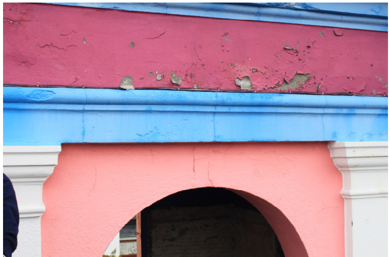
Murstykke over rundbue på tårn
