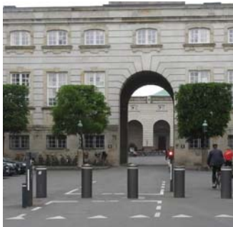
Dynamiske pullerter, Christiansborg
