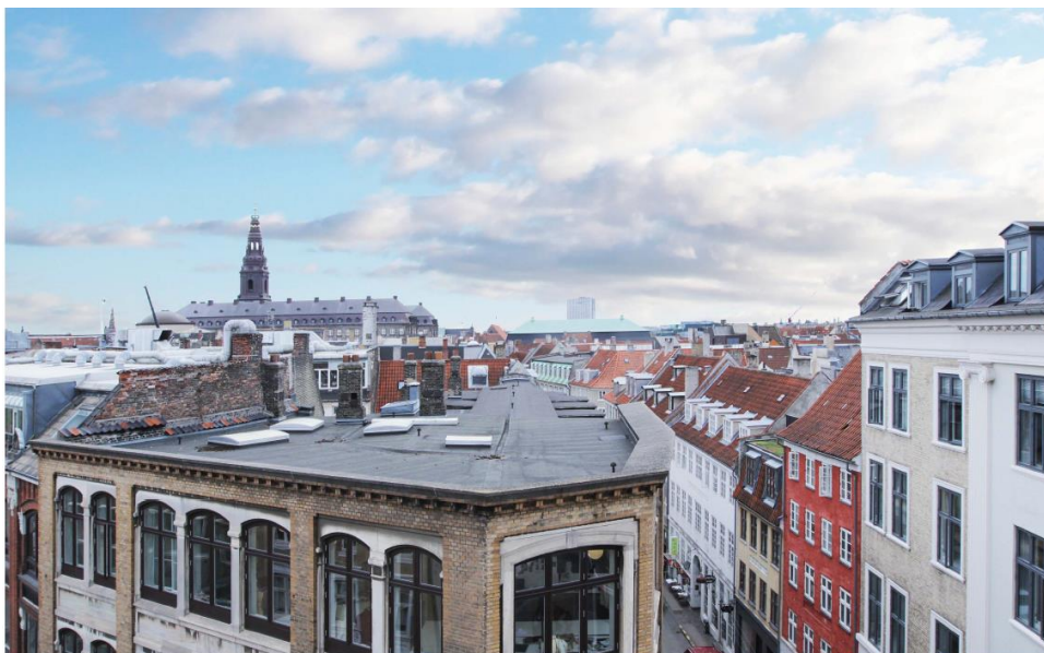
Eksempel på en eksisterende bygning opført med fladt tag, her Vimmelskaftet 45
