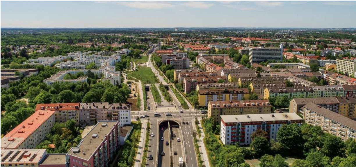
Einfahrt zum Heckenstallertunnel.
