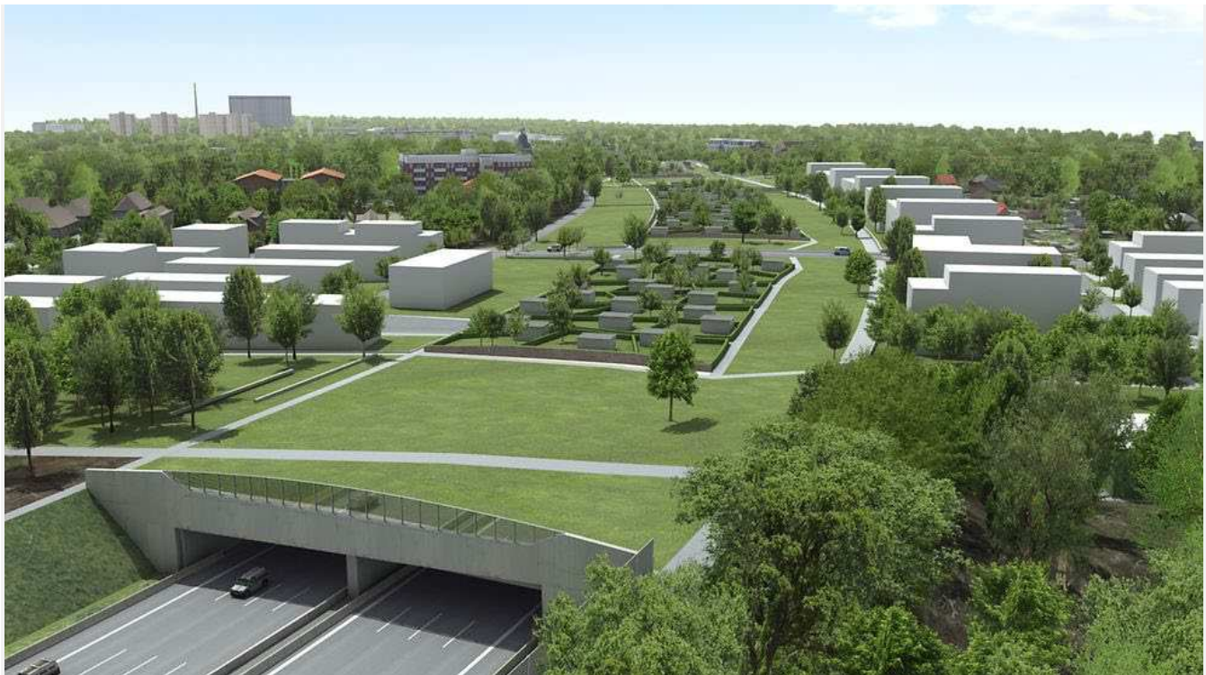
Fremtidig tunnelindgang: sofistikeret design af støjbeskyttelsesstrukturene Bild: © DEGES/V-KON.media
