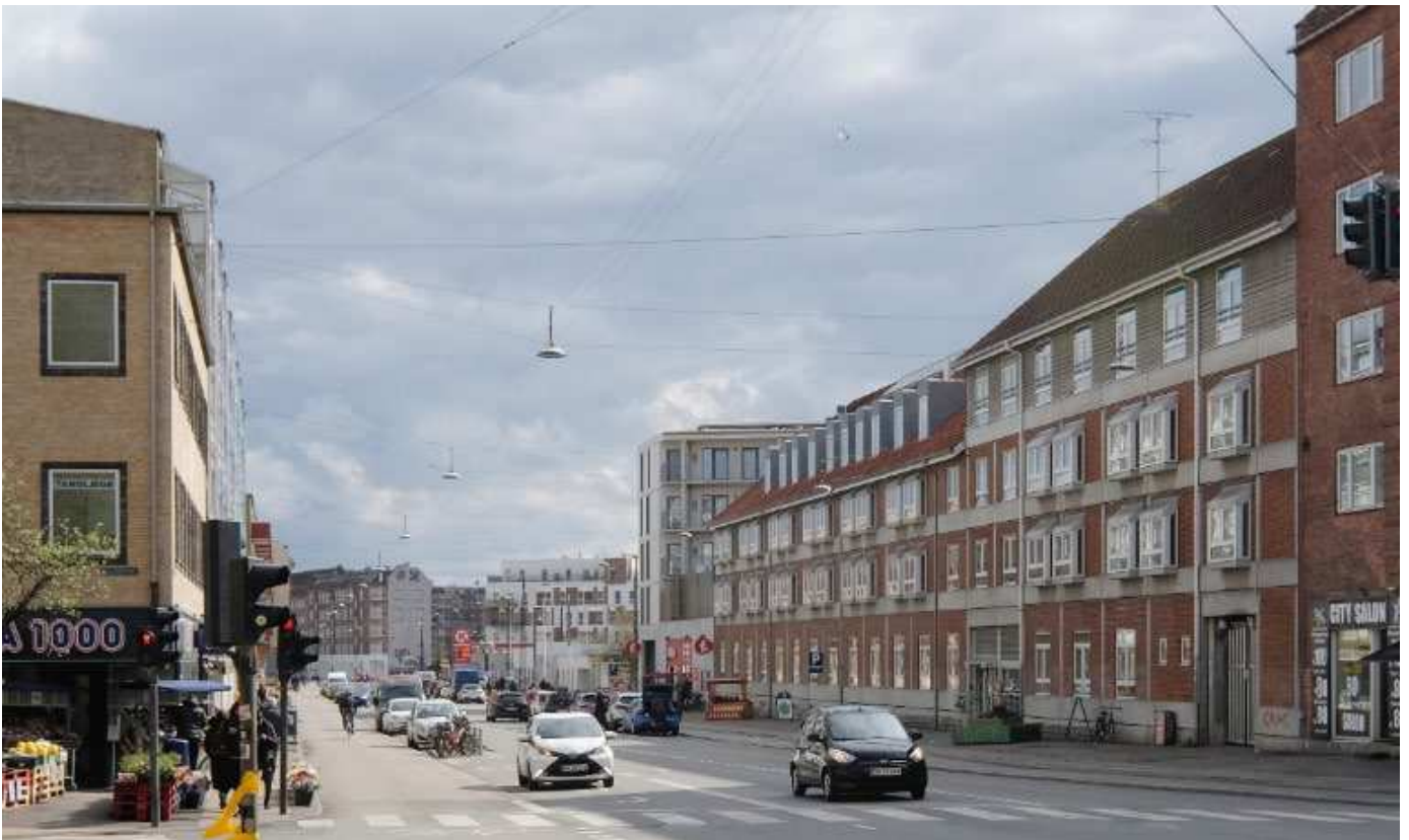
Område I - Dortheagården til højre i billedet set fra nord fra hjørnet af Frederiksborgvej og Birkedommervej.
