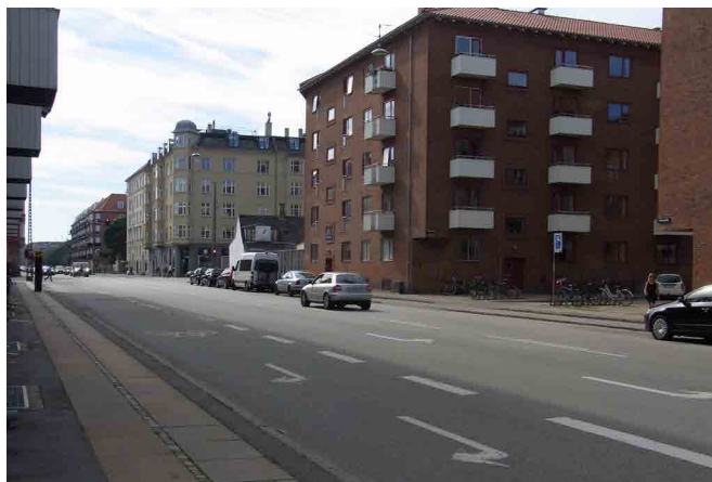
Moselgade som går i forlængelse af Kastrupvej. Foto: Københavns Kommune.
