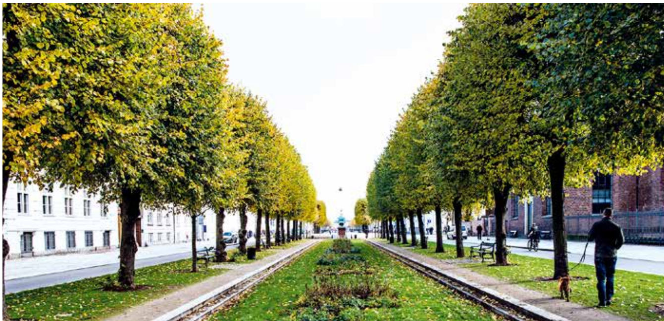
Skybrudssikring ved Skt. Annæ Plads.
