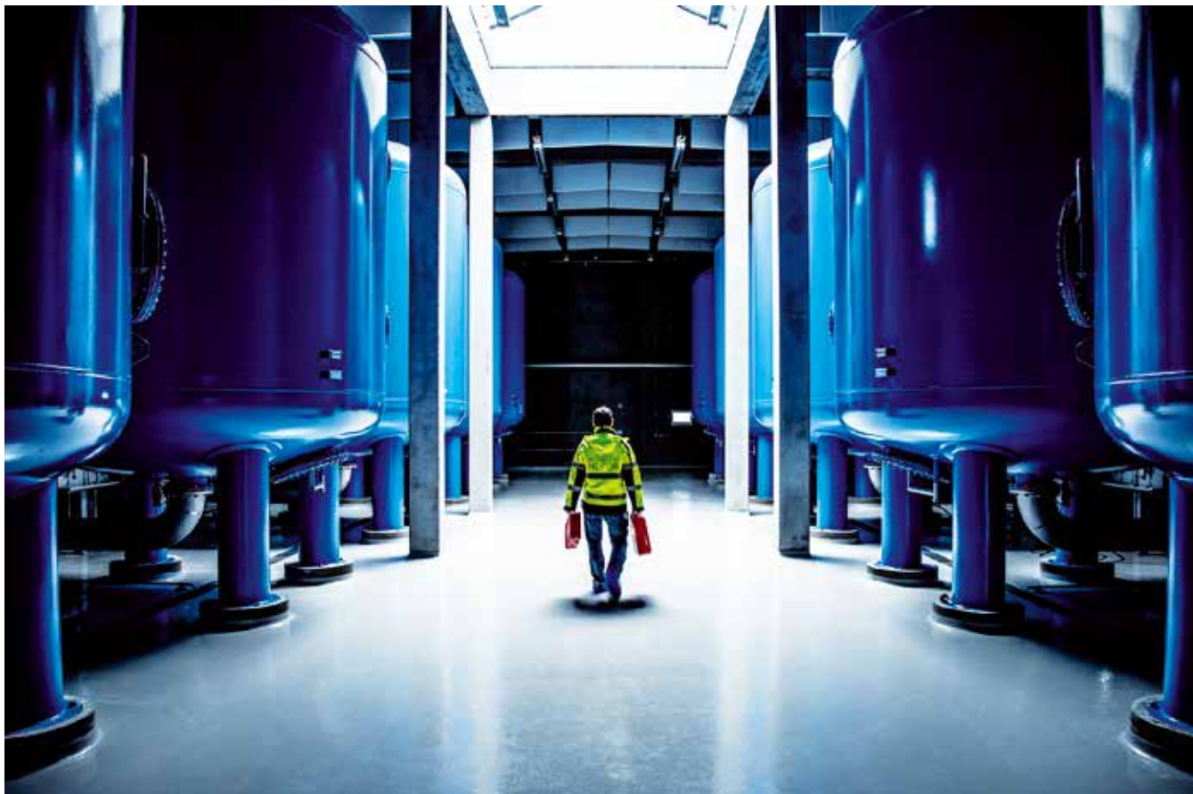
Værket ved Marbjerg.
