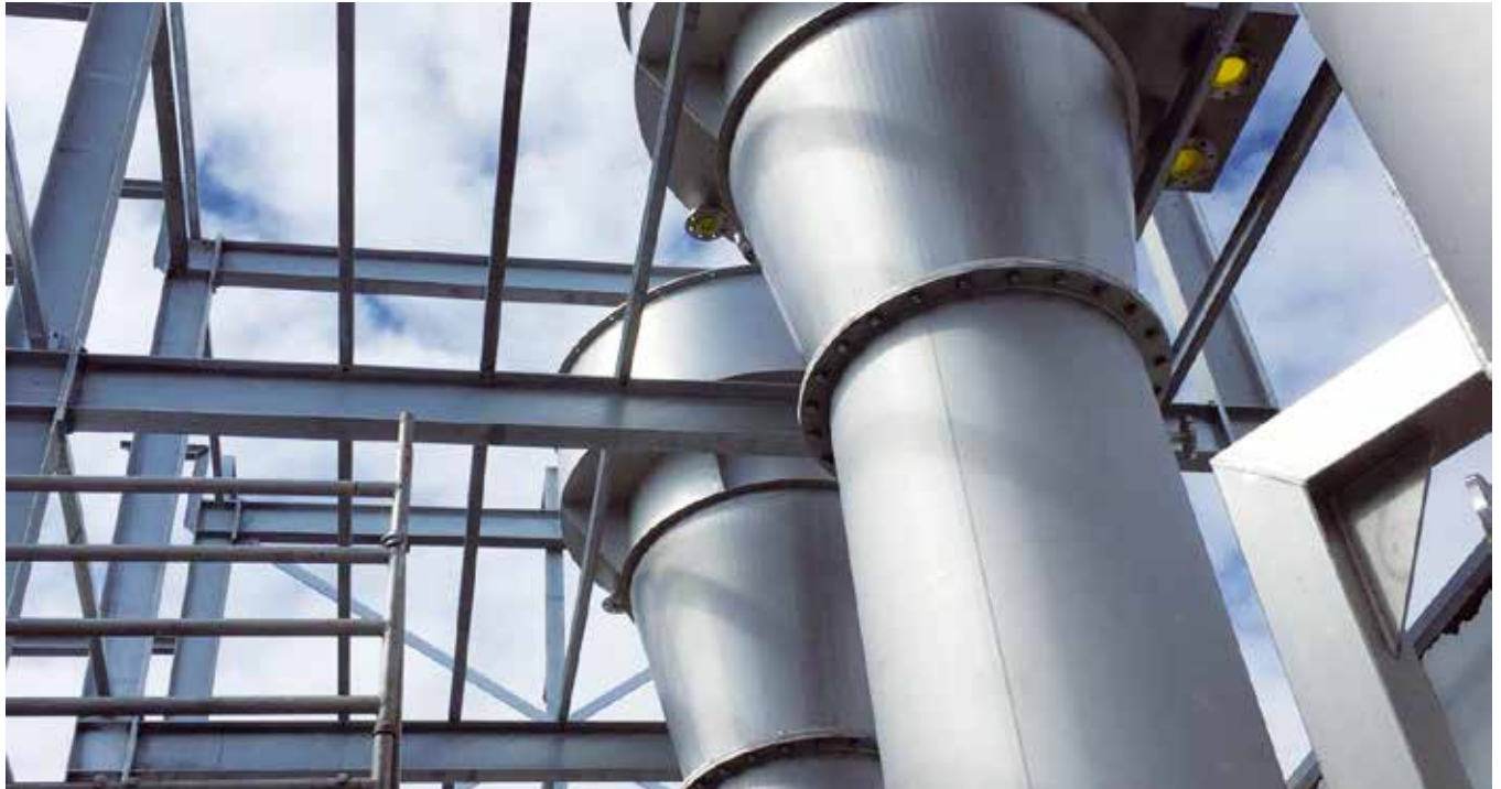
Brøndby Vandværk – Afkalkningstankene under renovering.
