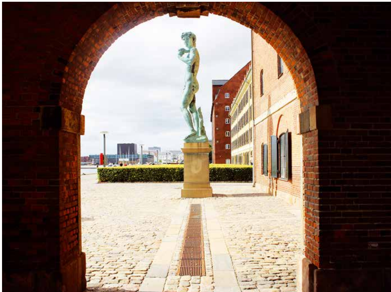
Den Kgl. Afstøbningssamling – Skybrudsriste i indre by.
