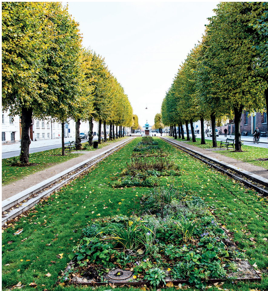
Skt. Annæ Plads i Indre By blev indviet i juni 2016. Pladsen er nu indrettet til at forsinke og opsamle regnvand, som tidligere oversvømmede gaderne i kvarteret.
