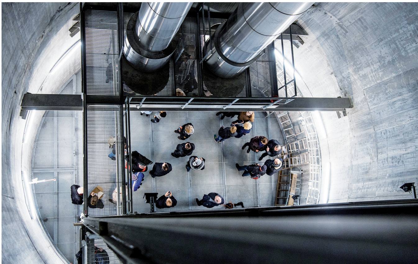
I forbindelse med varmens dag inviterede HOFOR til en gåtur under havnen i den nyindrettede fjernvarmetunnel. Det var en stor succes, og flere tusinde borgere gik de 300 m i tunnelen fra Islands Brygge til Kalvebod Brygge - 25 meter under havoverfladen.
