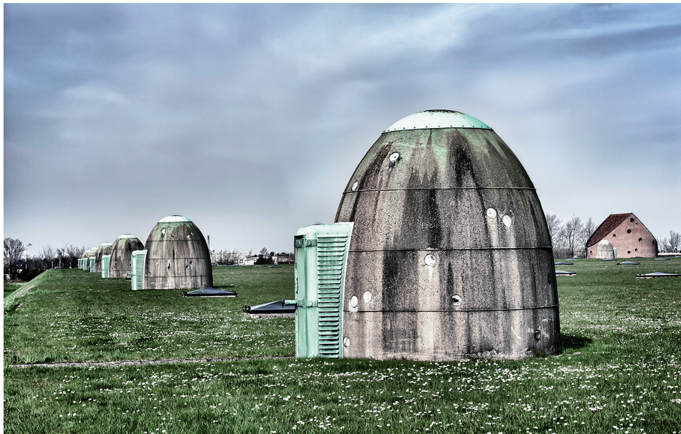
Beholder 12 ved Tinghøj er blevet renoveret og kan opbevare 63.000m 3 drikkevand.
