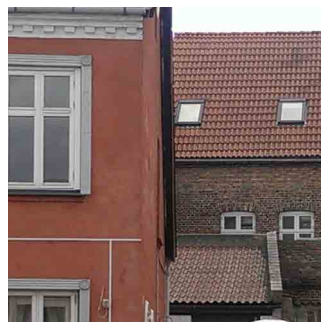
Tagbeklædning. Rødt tegtag, rød puds og gule mursten.
