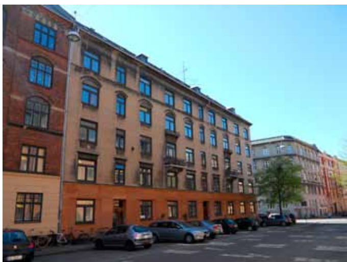
Facade mod Ægirsgade
