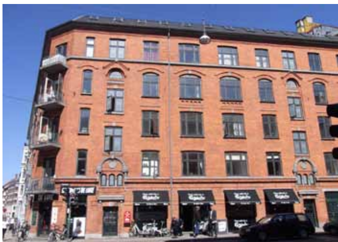
Facade mod Ægirsgade
