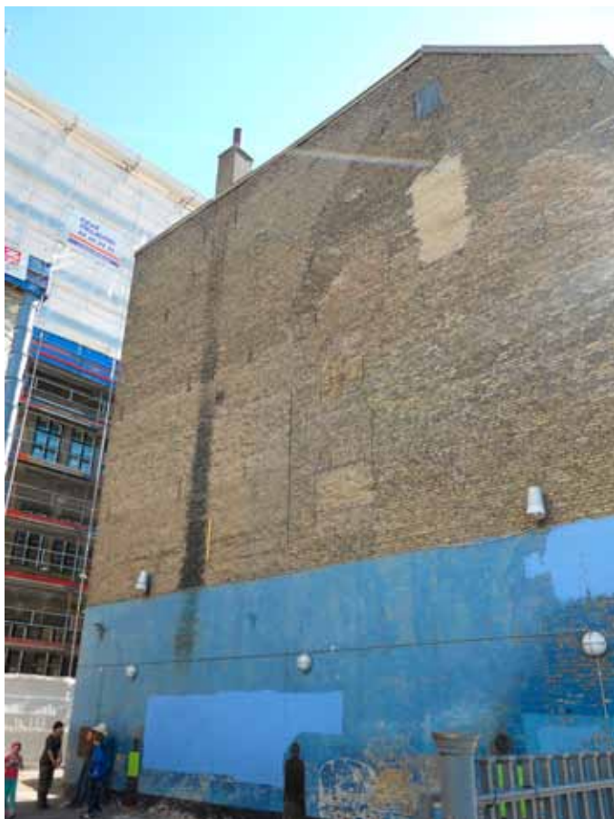
Gavl mod Sølvgade Skole
