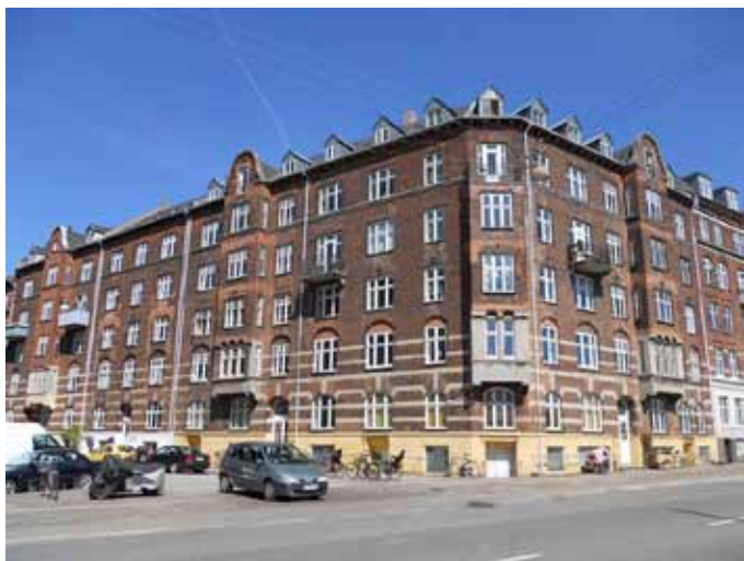
Facade mod Godsbanegade og Ingerslevgade
