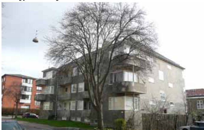
Gavl og facade mod gade
