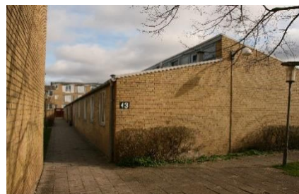
Institutionsbygninger i 1 etage og med forskudte tage
