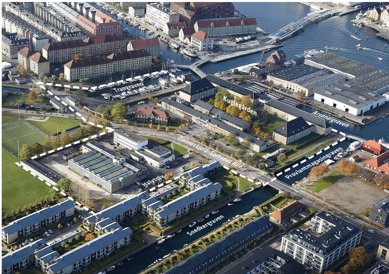
Skråfoto af lokalplantillægsområdet. JW Luftfoto, oktober 2016.
