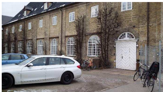
Bygningen mod Trangraven, hvor der endnu ikke er foretaget et større indgreb, man vil ikke kunne se bygningen for det nye hotel.
