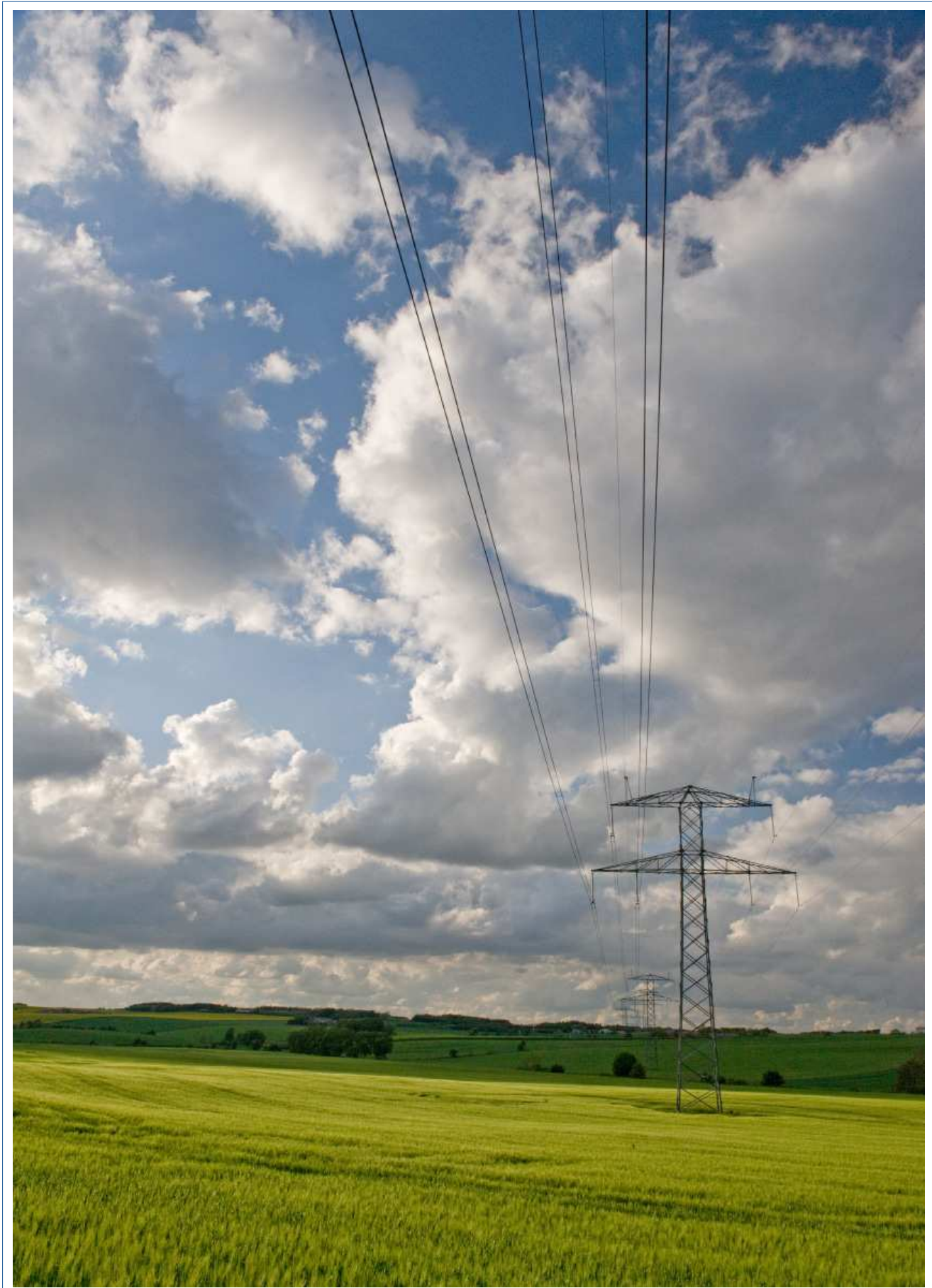
Masterække med et 400 kV ledningssystem og et 150 kV system. Når to systemer samles på én masterække, bliver magnetfelterne ikke automatisk dobbelt så store. De kan i nogen grad udligne hinanden.
