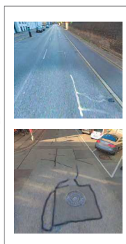
Asfaltforsejlinger i Sølvgade og Rigsgade.
