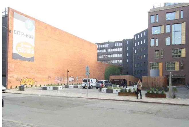
Adelgade med den nye plads ved Turbinehuset
