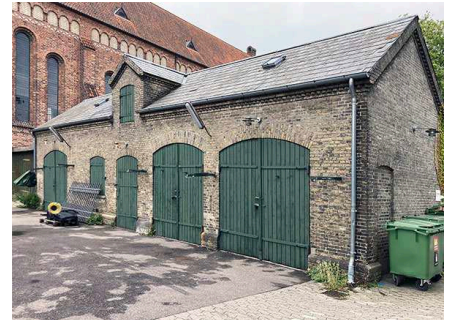
Bygning 11. Stald og gartnerbolig.
