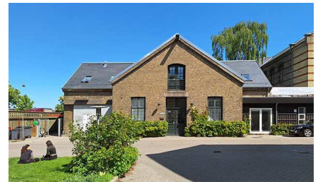
Bygning 6. Ishus og desinfektionsbygning.
