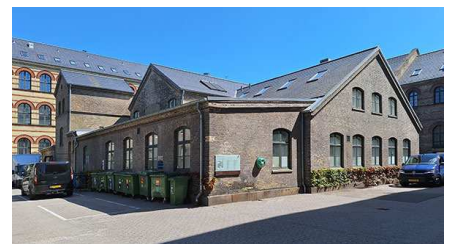
Bygning 20. Kedel- og maskinhus.
