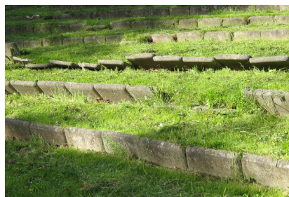
Siddekanterne bør renoveres med en kombination af nye og genbrugte betonsten, og siddepladserne rettes op
