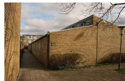
Institutionsbygninger i 1 etage og med forskudte tage
