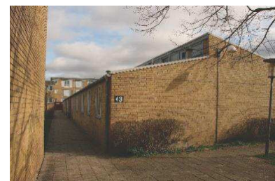
Institutionsbygninger i 1 etage og med forskudte tage
