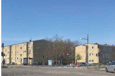
Nuværende facade på Åkandevej, set mod syd/vest.
