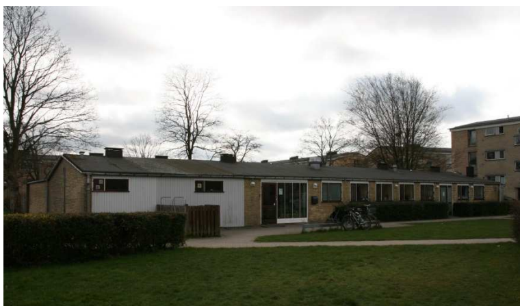
Den fritliggende fløj set fra nord
