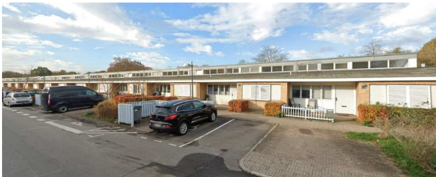
Udsnit af rækkehusets nordlige østfacade
