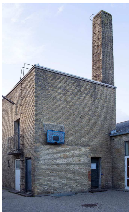
Engvej 143 – Kedelhus opført i 1961.
