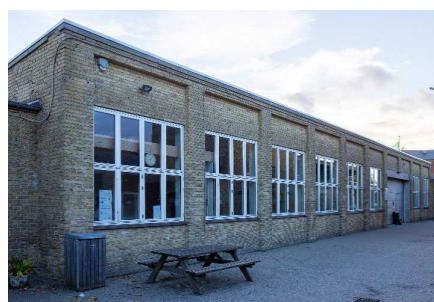
Engvej 145 – Fabriksbygning opført i 1961.
