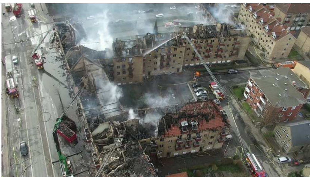
Figur 16: De skadede bygninger på Grøndals Parkvej
