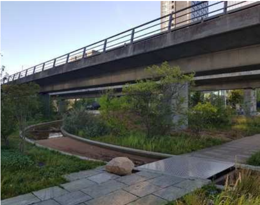
Figur 4.26 Eksempel på eksisterende dobbelt viadukt fra M1 Ørestad.
