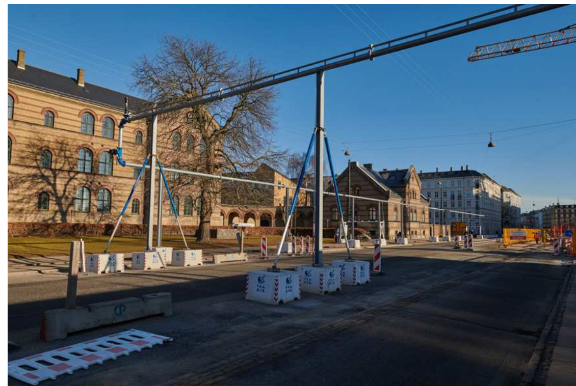
Figur 13.14 Eksempel på ledningsnet til reinfiltrationsboringer.
