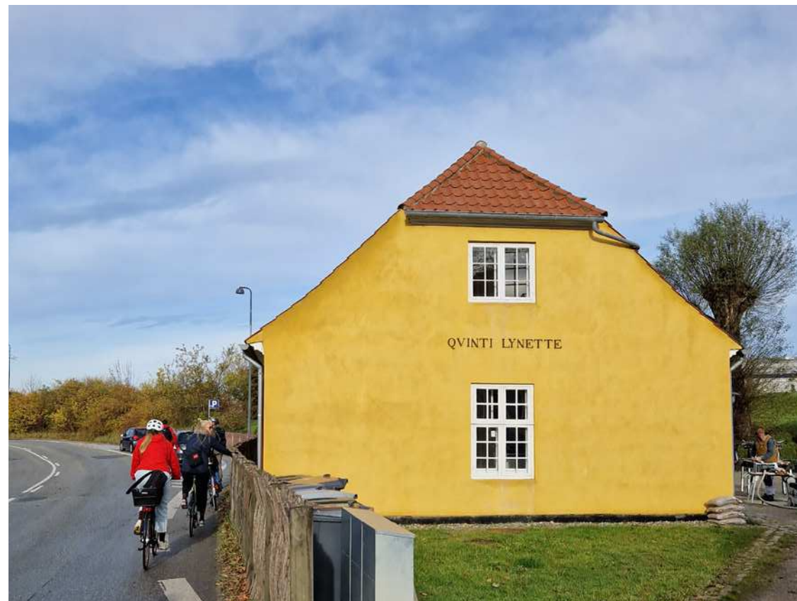
Figur 17.5 Den fredede bygning ved Qvintus bastion.
