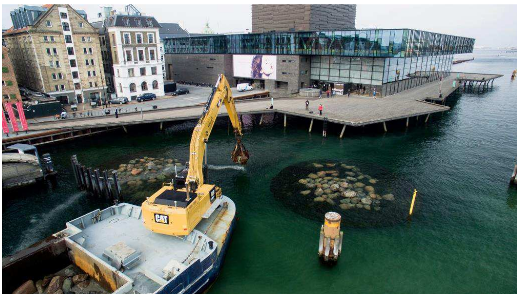
Etablering af stenrev ved Skuespilhuset 2017.
