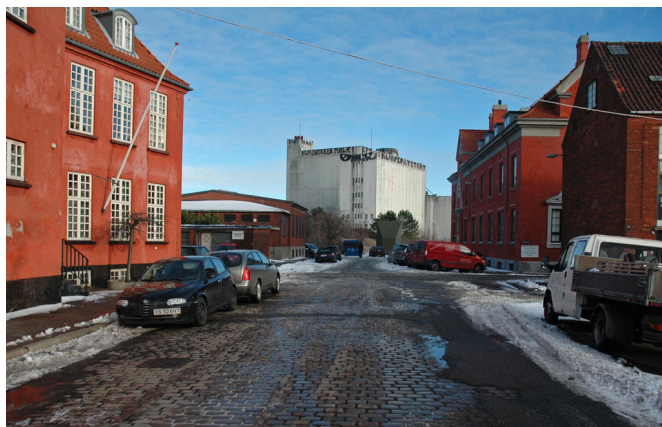
Århusgade med de bevaringsværdige siloer og bebyggelsesmiljøer
