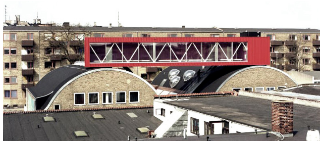
Referencefoto jf. § 6, stk. 10. Eksempel på påbygning som selvstændigt arkitektonisk og konstruktivt element. Sjakket, København, ark. PLOT
