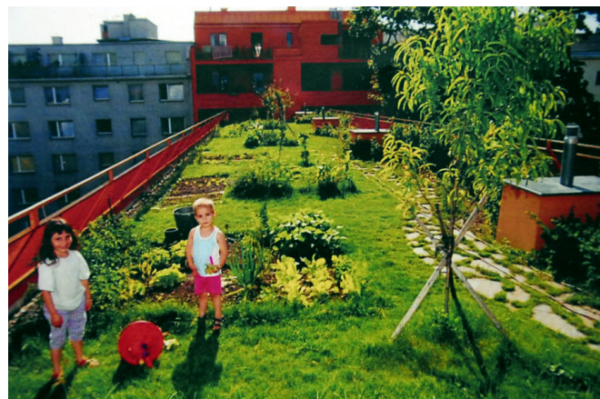
Referencefoto jf. § 7, stk. 8. Grønt tag med regnvandsforsinkelse og opholdsmulighed
