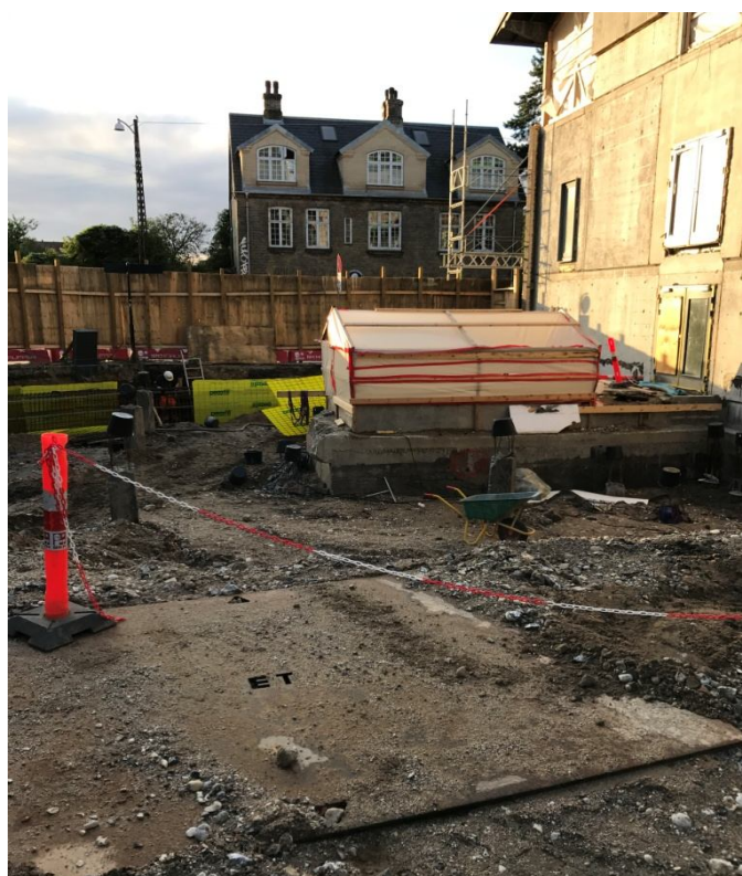
Fra byggepladsen ved gymnastiksalsbygningen
