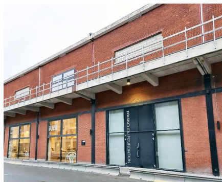
Bevaringsværdig bygning – Pakhus 53.
