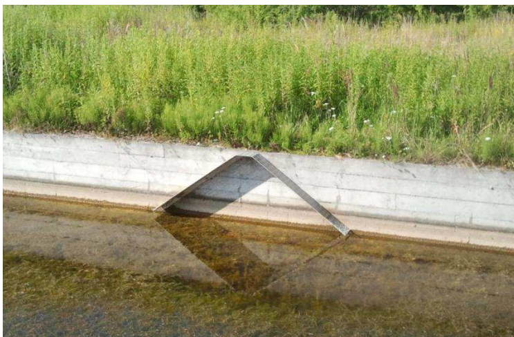
Figur 37. I stedet for en skrå og blød overgangszon er kanalens kanter hårde og lodrette betonkanter som dårligt opfylder de biologiske behov i området. Der er med store mellemrum opsat ramper som kompensation for dyrelivet, men bemærk luft under den nederste kant pga. lav vandstand
