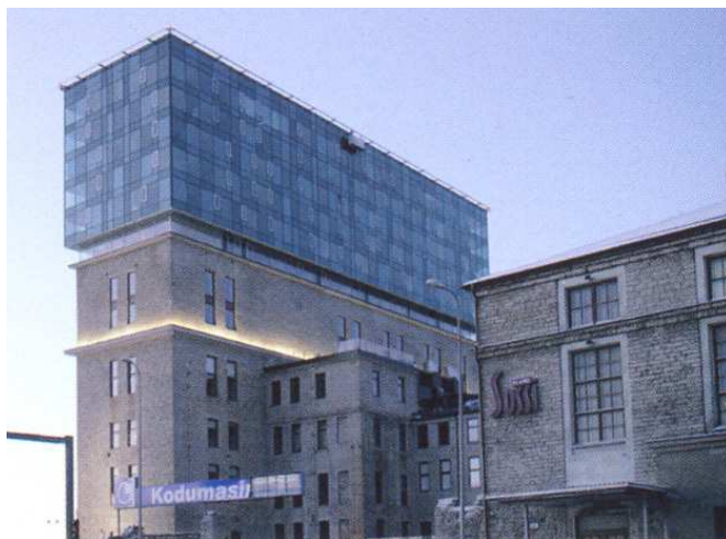
Referencefoto jf. § 6, stk. 10. Eksempel på tagudvidelse, som markant arkitektoniske brud med den eksisterende bygning. Fahle House, Tallinn, ark. KOKO
