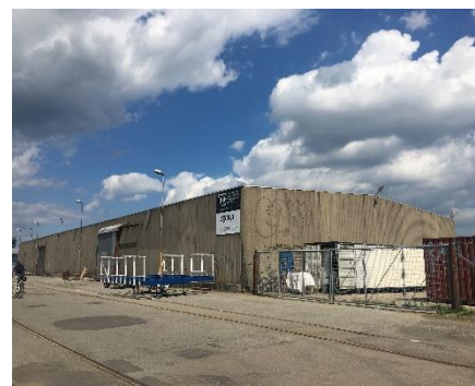
Eksisterende lagerhal ved Kalkbrænderiløbskaj. Forrest ses den nuværende belægning med asfalt og jernbaneskinner.
