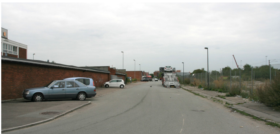
Blushøjvej set mod nord. Byggegrunden til EAT-centralkøkken ligger til højre.
