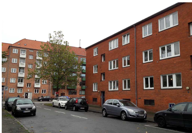
Boligbebyggelse på Lønstrupvej og Ålekistevej.
