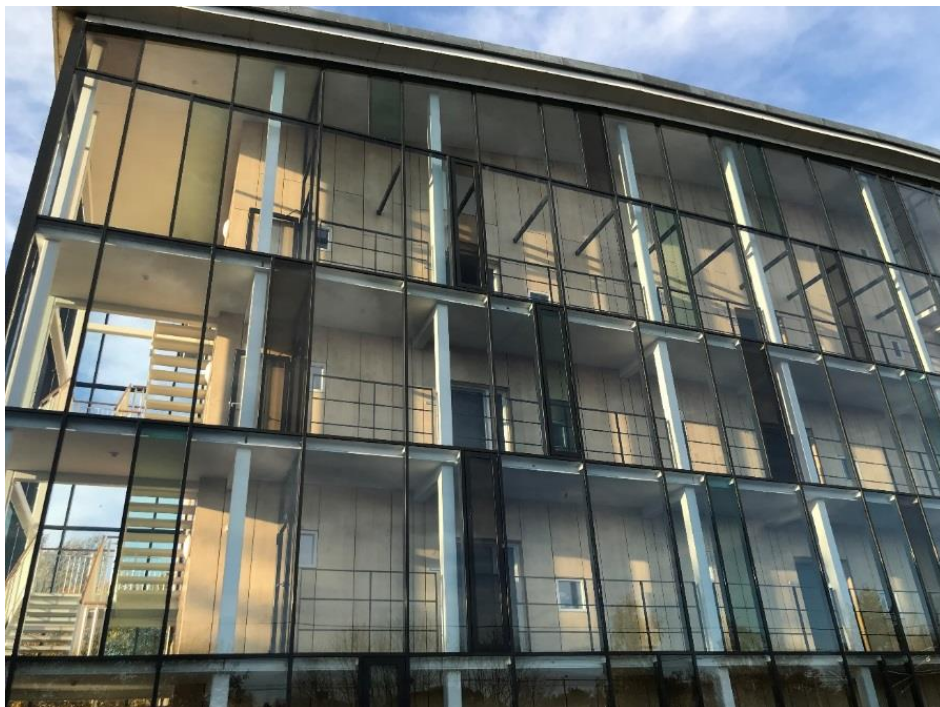
Figur B3 Billedet viser Baune Allé 2, 2800 Kgs. Lyngby som et eksempel på en boligejendom med altangang som støjbeskyttelse mod vej og jernbane. Foto: Rambøll.
