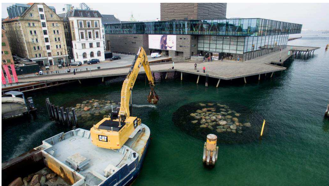
Etablering af stenrev ved Skuespilhuset 2017.
