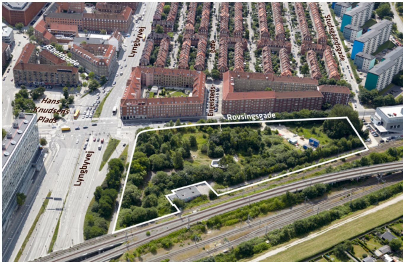
Lokalplanområdet set mod sydøst. JW Luftfoto juli 2013.
