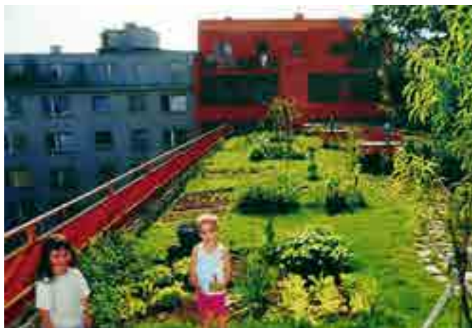
Reference 7.7. Grønt tag med regnvandsforsinkelse og opholdsmulighed.
