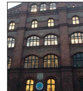
FACADER FRA FØRSKELLIGE BYGGE-PERIODER
